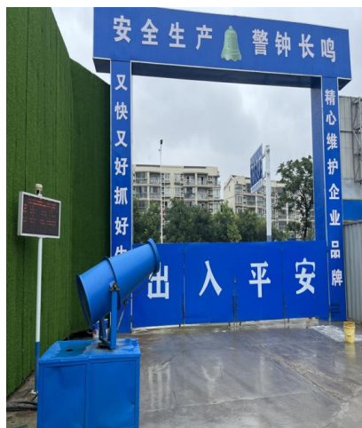
施工期雾炮机（大气防治）
