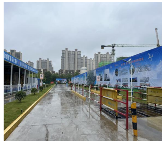
施工期过水池
